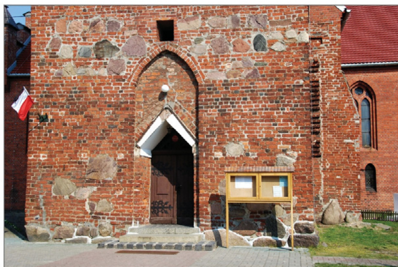
B. Polanów, kościół p.w. Wniebowzięcia NMP, głązy narzutowe użyto do budowy późnogotyckiej wieży. Fot. W. Florek, 4.04.2010
