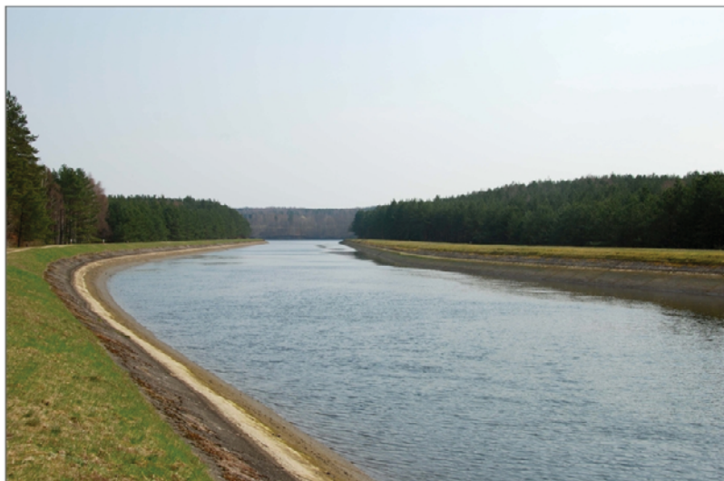
A. Kanał roboczy elektrowni Żydowo łączący jezioro Kamienne z rurociągami. Fot. W. Florek, 4.04.2010
